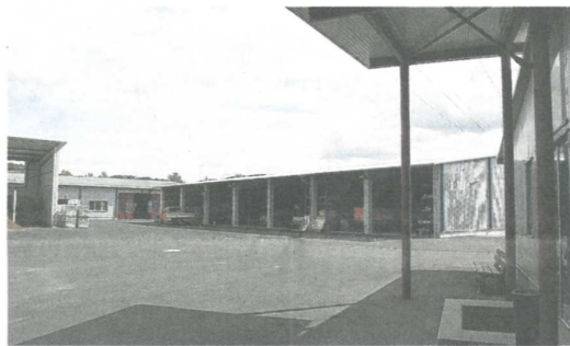
Auf den Dächern des städtischen Bauhofs von Bad Neustadt soll die erste Photovoltaik-Anlage der Friedrich-Wilhelm Raiffeisen Energie eG entstehen. FOTO H. HERBERT
