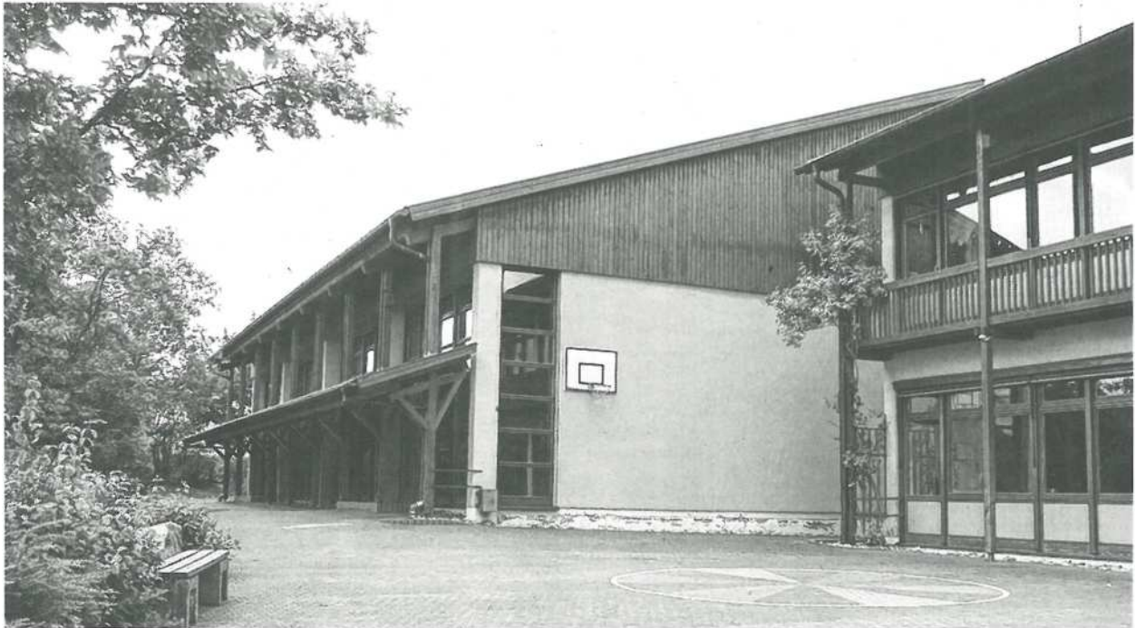
Auf den südlichen Dachflächen der Turnhalle und Schule in Sandberg soll noch in diesem Jahr eine Photovoltaikanlage entstehen.
