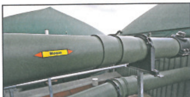
Die Biogasanlage kann etwa 1730 Haushalte mit Strom versorgen.
